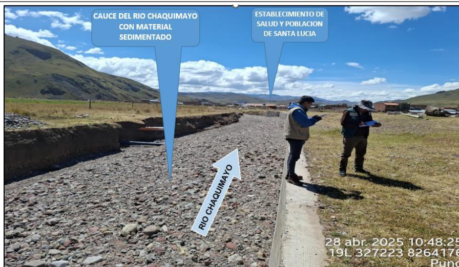
FIGURA 1 y 2 : TRAMO CRÍTICO EN EL RÍO CHAQUIMAYO, EN EL SECTOR SANTA LUCÍA, DISTRITO DE SANTA LUCÍA, PROVINCIA DE LAMPA - PUNO. NOTESE, LA ACUMULACION DE MATERIAL SEDIMENTADO EN EL CAUCE, QUE REQUIERE SER ELIMINADO PARA REESTABLECER LA SECCIÓN HIDRAULICA DE LA CAJA DEL CAUCE EN ESTE SECTOR.
